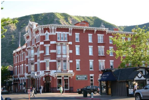
1887年に建てられたストラターホテル
